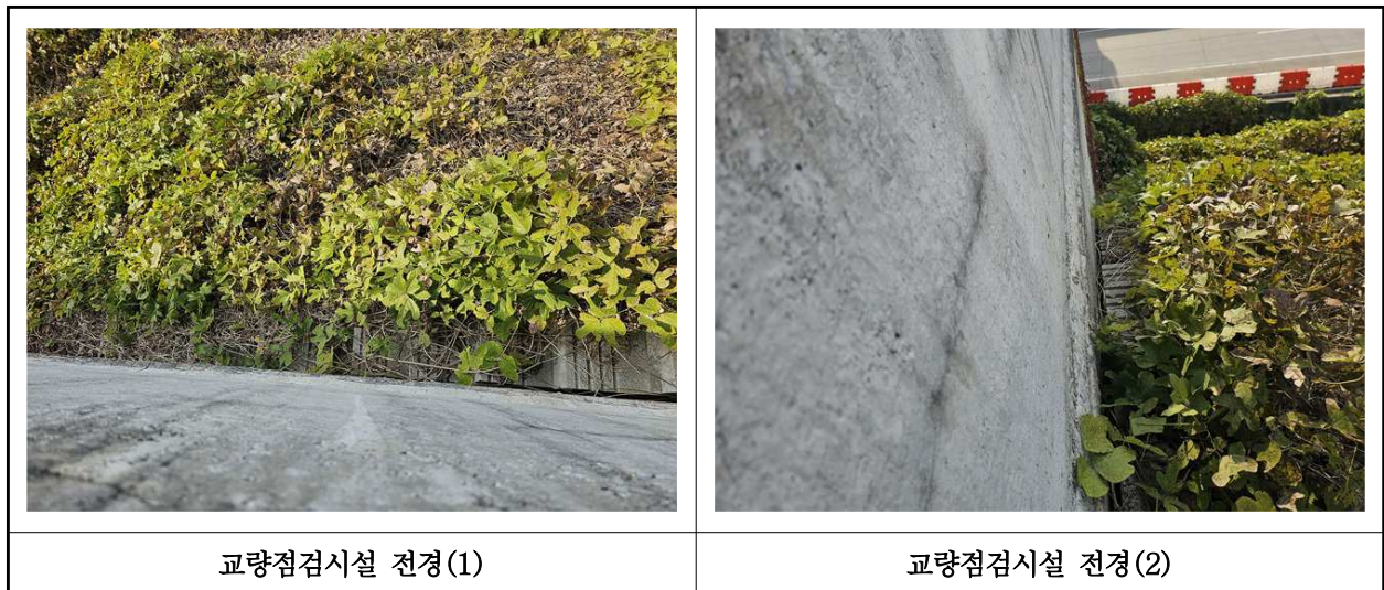
【사진 23.3.21】 교량 점검시설 전경
