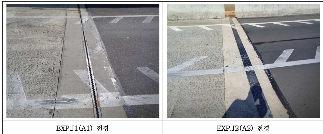
【사진 23.3.14】 신축이음장치 전경
