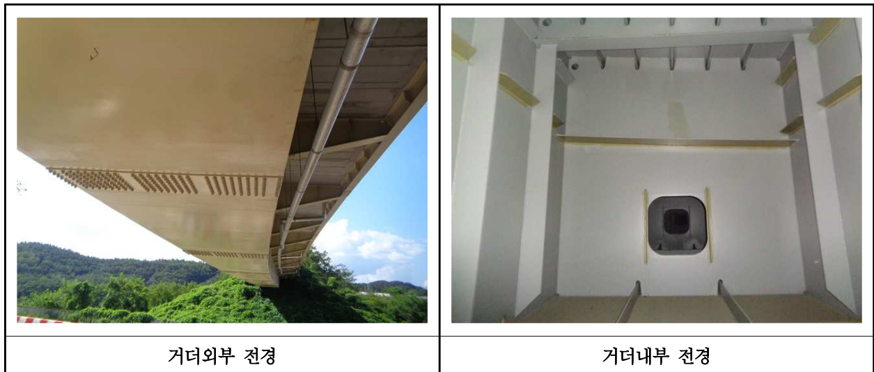
【사진 23.3.4】 거더 전경
