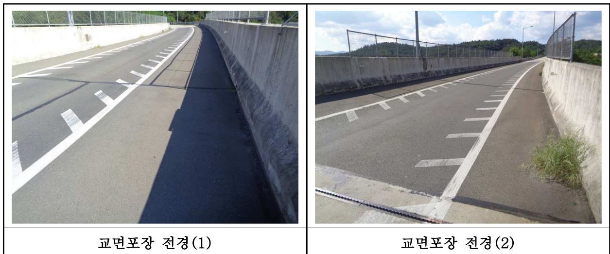
【사진 23.3.17】 교면포장 전경
